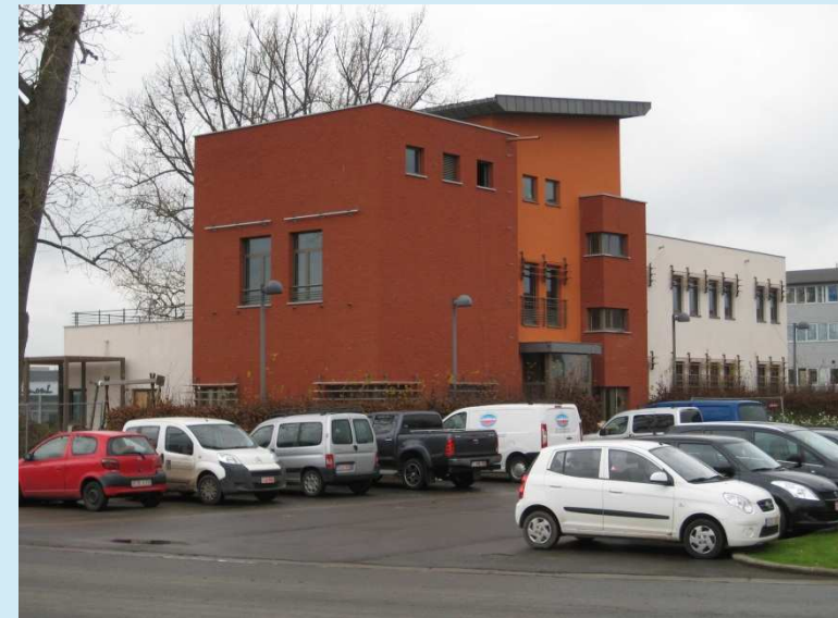
Centre de Services Auxiliaires Saintes
