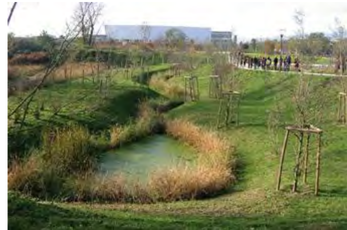
Bassin d'orage paysager avec lame d'eau permanente + noue ©JNC
