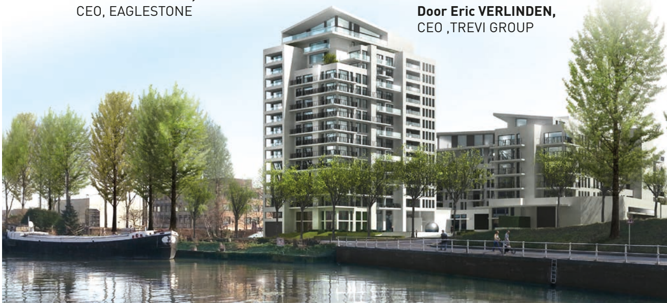
De Nautilus, Vaartdijk te Anderlecht: een project van 200 appartementen dat momenteel wordt ontwikkeld door Eaglestone langs het Kanaal. Een nieuwe generatie projecten tegen betaalbare prijzen die in de filosofie van het demografische GBP past. [Doc. Eaglestone; Arch. AXENT]
